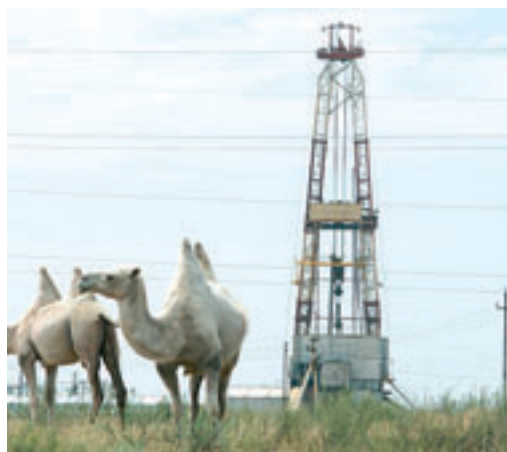
Эксплуатационная скважина на АГКМ.
