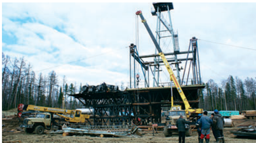
Вышкомонтажные работы на скважино-точке № 14 Чиканская (фото А. Коновалова).
